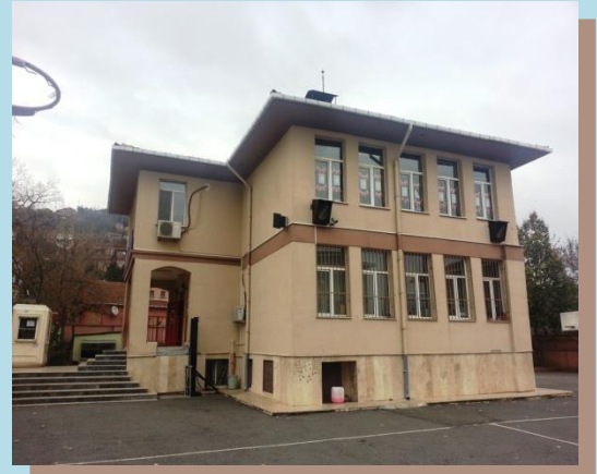
( A Blok Yan Görünüm)
